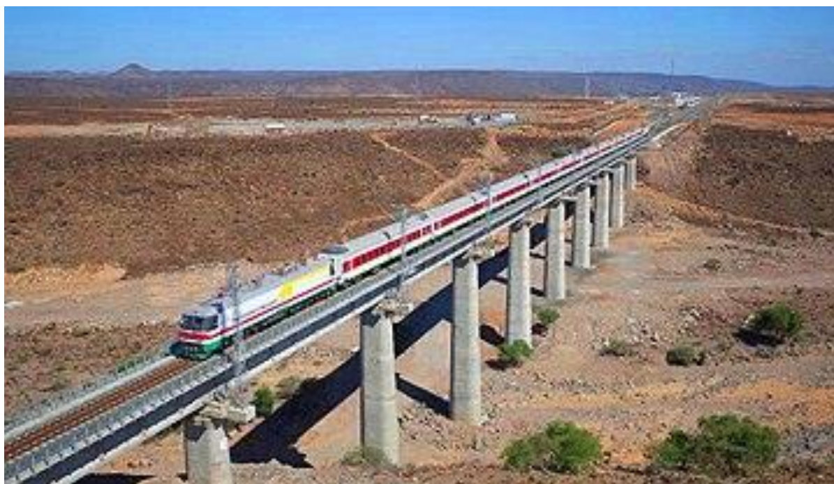
Figure 0-1: Le pont de Holhol sur la ligne ferroviaire Addis-Abeba-Djibouti
